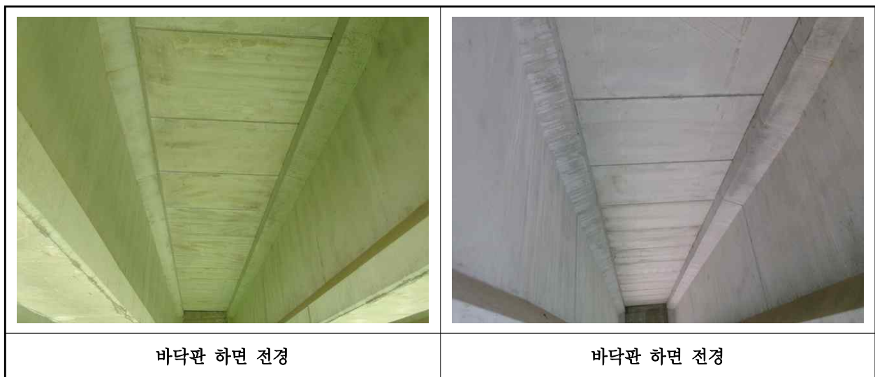
【사진 11.3.2】 바닥판하면 전경
