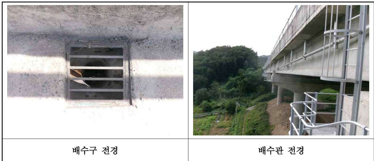
【사진 11.3.22】 배수시설 전경
