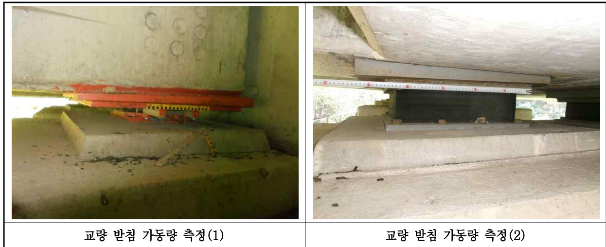
【사진 11.3.16】 교량받침 이동량 측정
