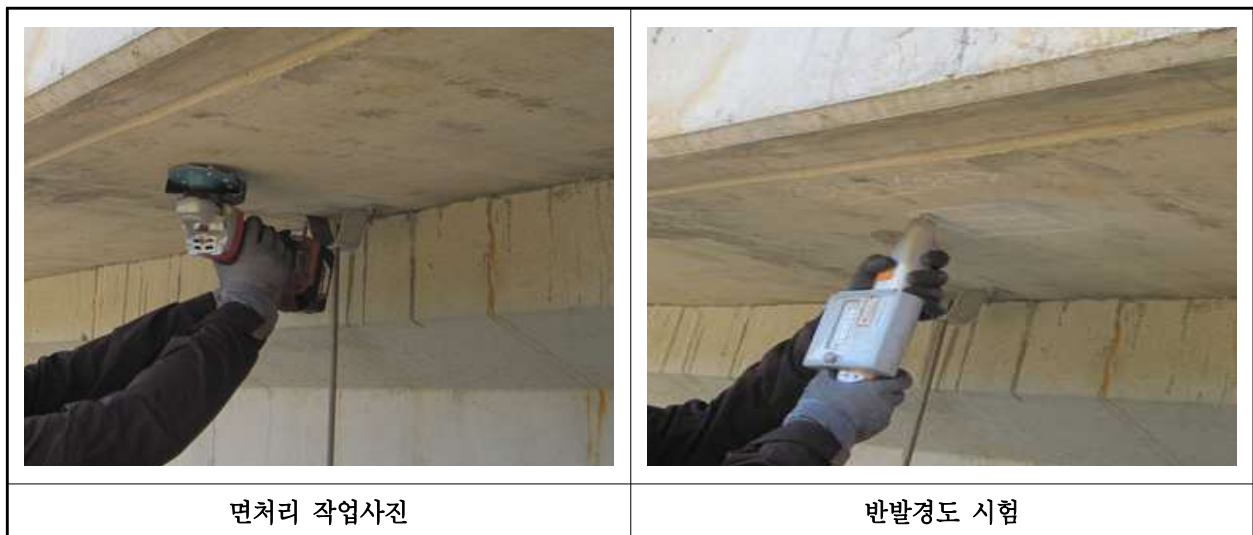
【사진 11.4.2】 반발경도시험 현장사진
