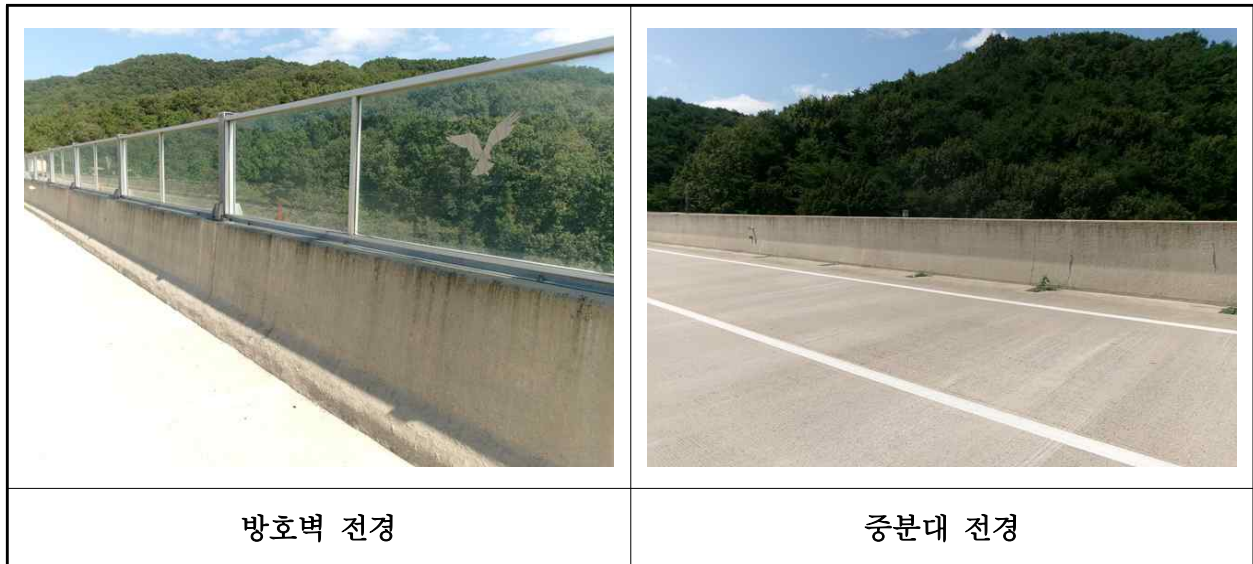
【사진 11.3.24】 방호벽 및 중앙분리대 전경
