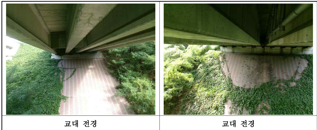
【사진 11.3.8】 교대 전경
