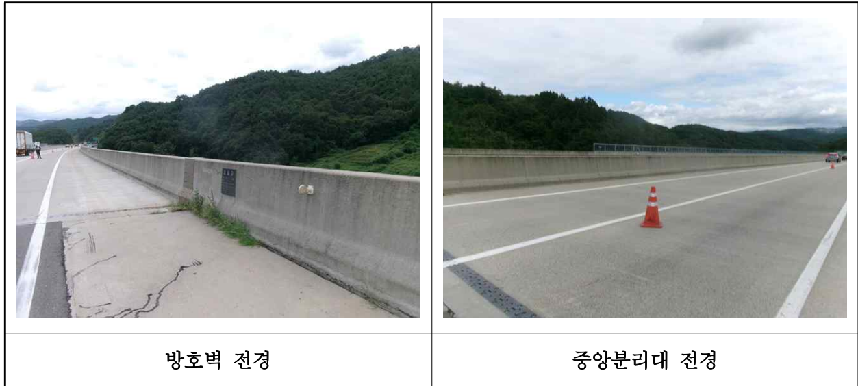
【사진 11.3.51】 방호벽 및 중앙분리대 전경
