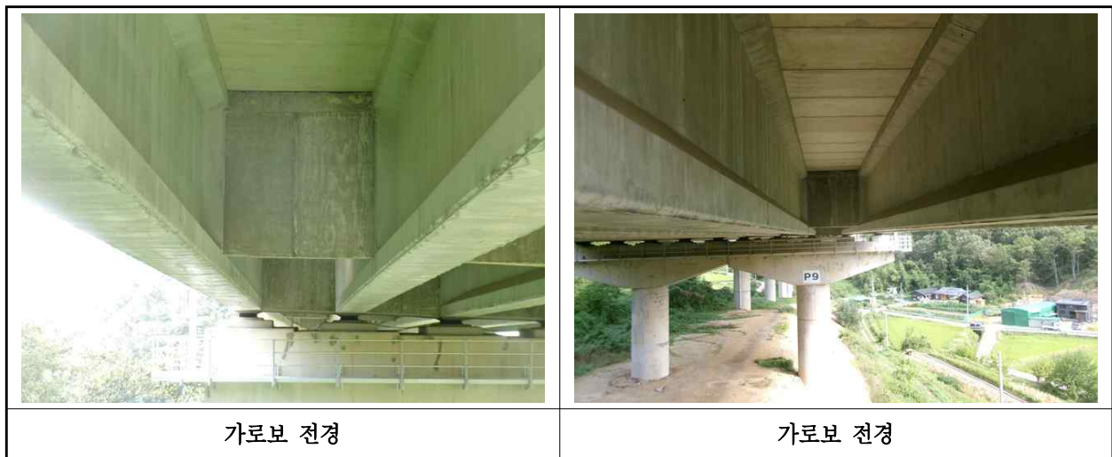
【사진 11.3.6】 가로보 전경
