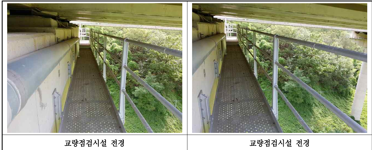
【사진 11.3.53】 교량 점검시설 전경
