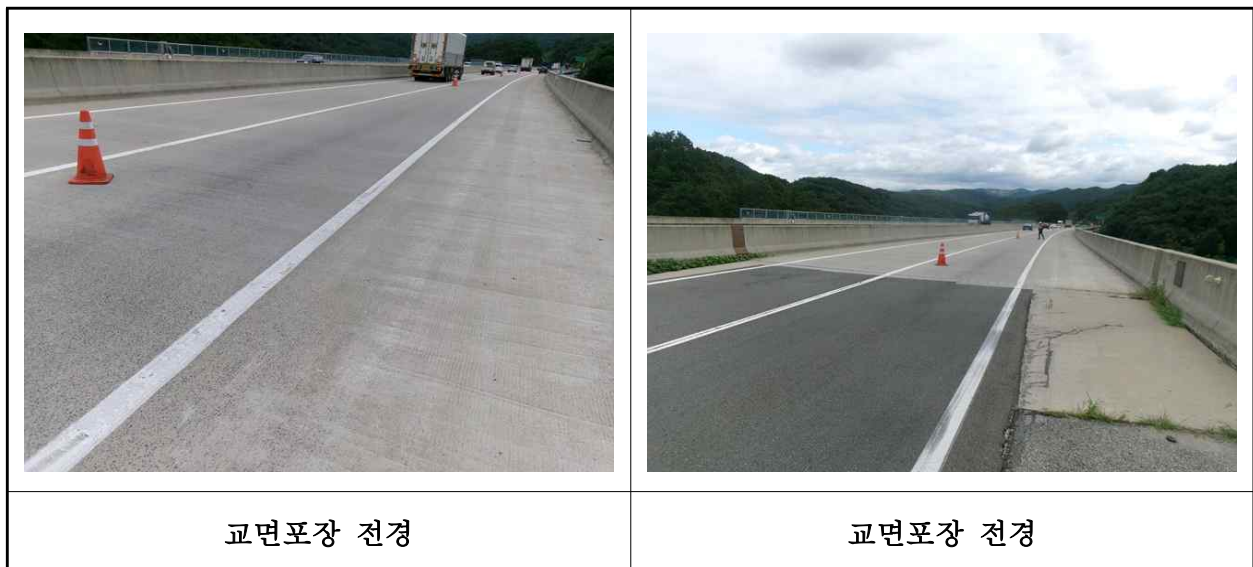
【사진 11.3.47】 교면포장 전경
