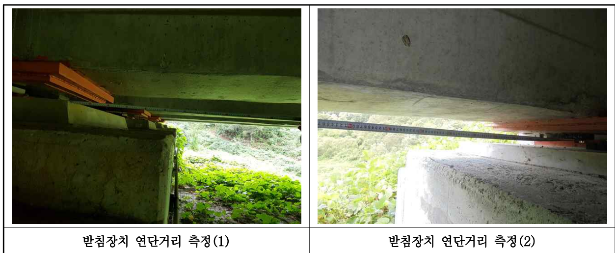
【사진 11.3.42】 교량받침장치 연단거리측정
