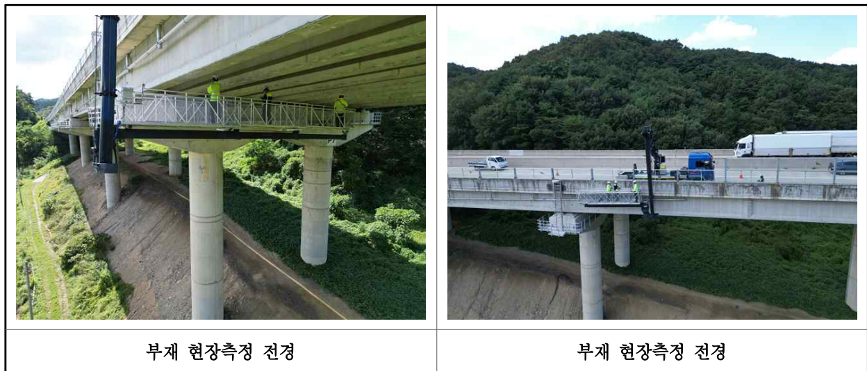
【사진 11.2.1】 부재 현장측정 전경
