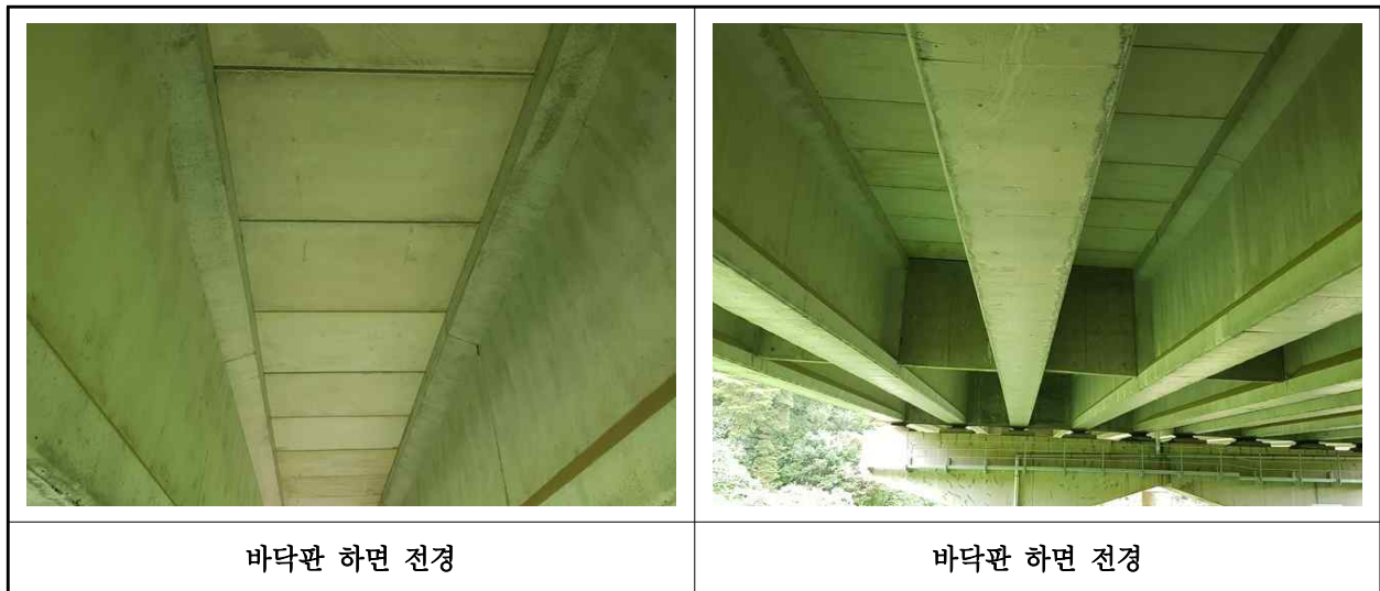
【사진 11.3.29】바닥판하면 전경
