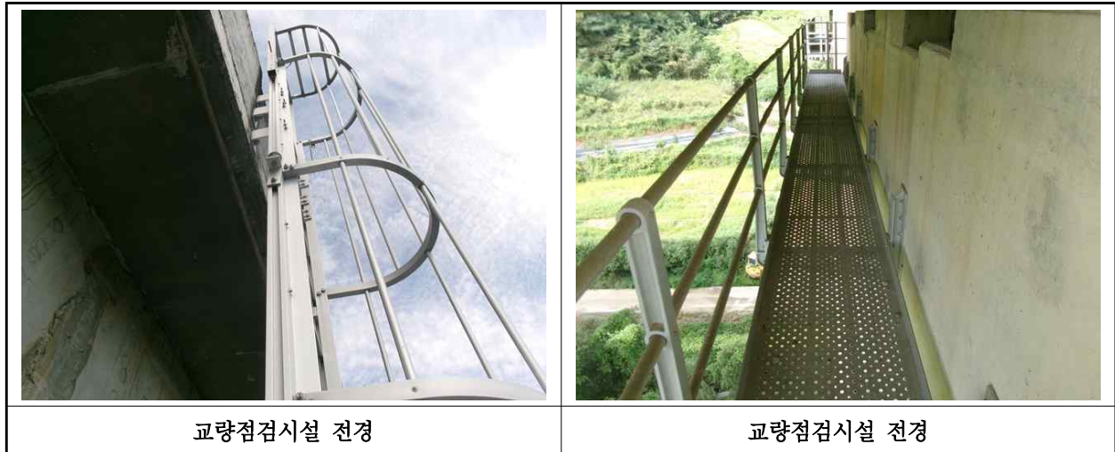
【사진 11.3.26】 교량 점검시설 전경
