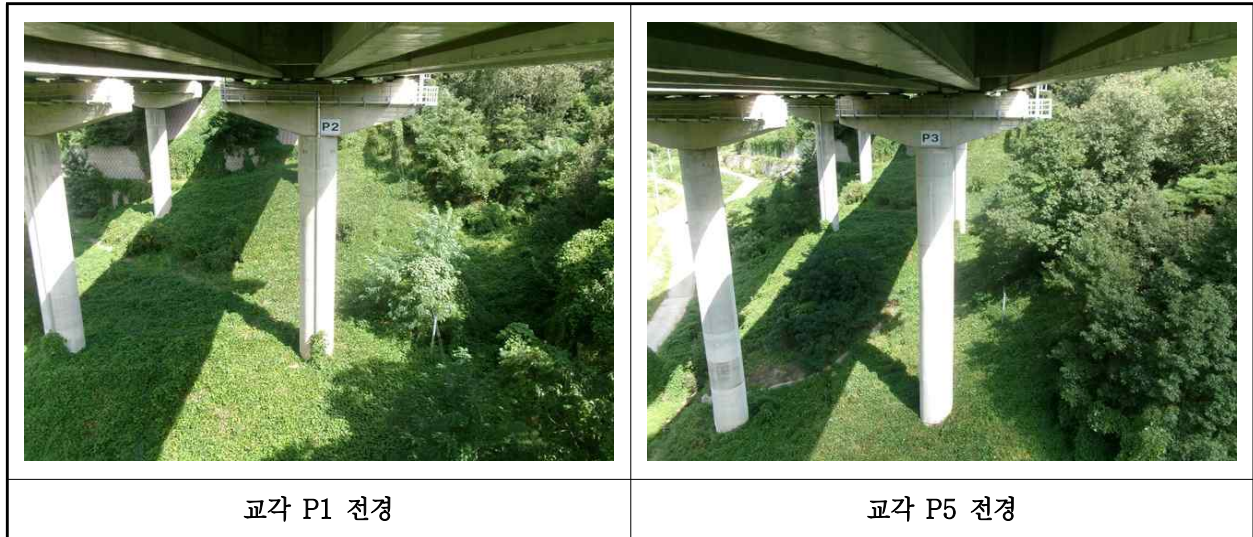
【사진 11.3.10】 교각 전경
