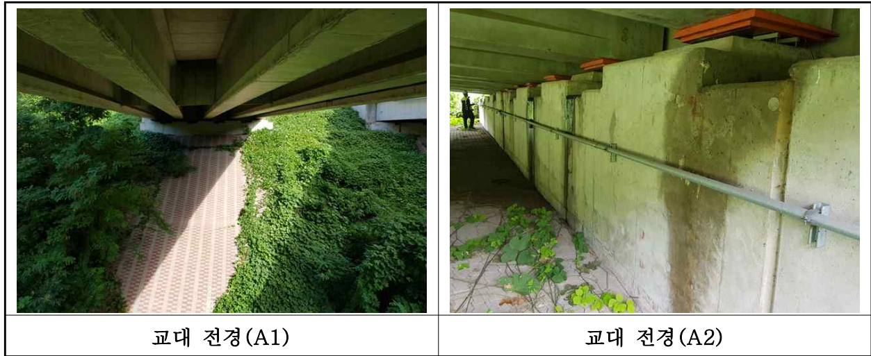
【사진 11.3.35】 교대 전경
