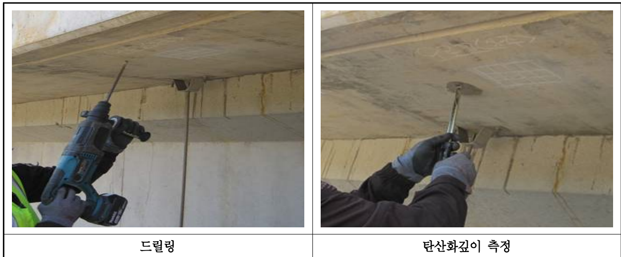
【사진 11.4.3】 탄산화 깊이 측정 현장사진
