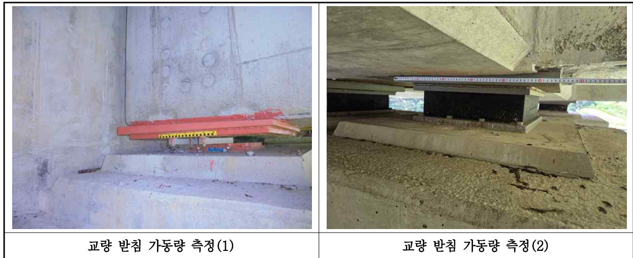
【사진 11.3.43】 교량받침 이동량 측정
