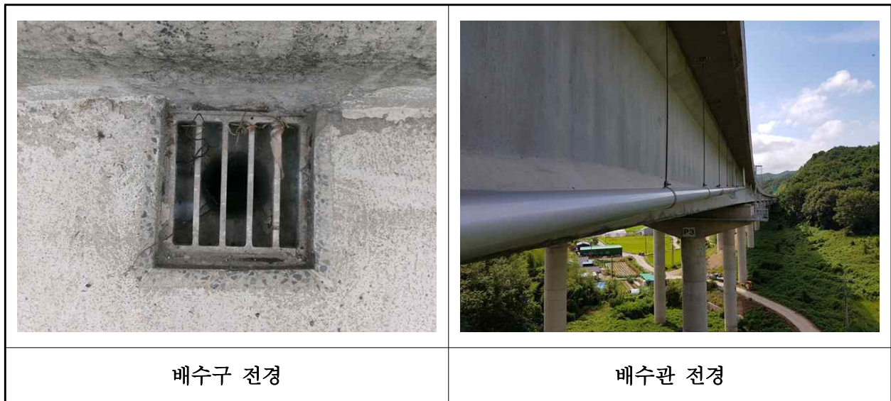
【사진 11.3.49】 배수시설 전경
