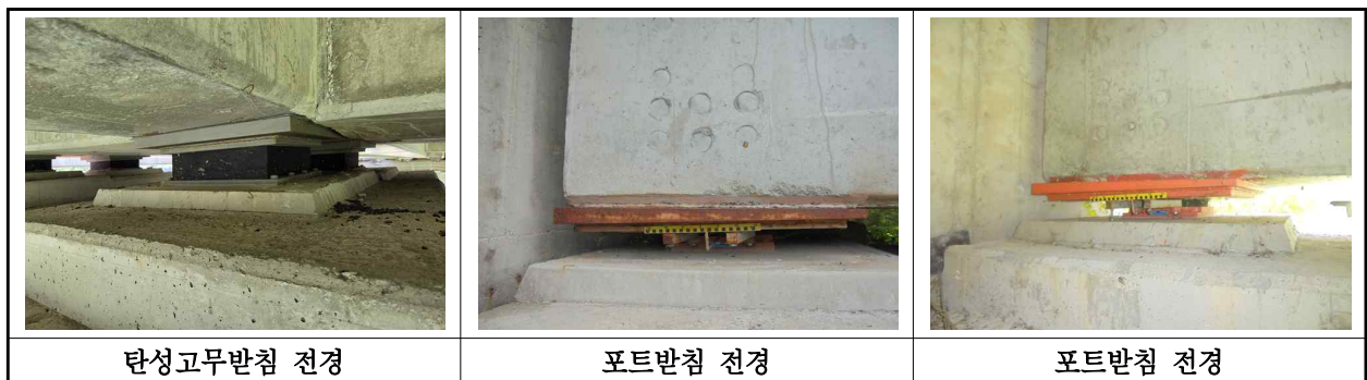
【사진 11.3.40】 교량반침 전경
