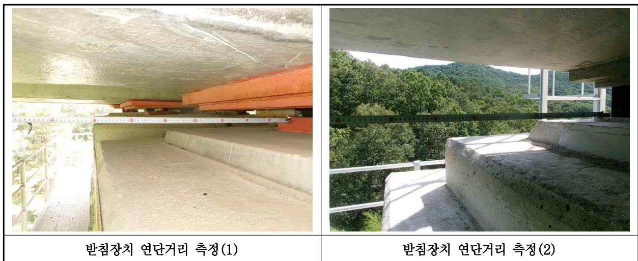
【사진 11.3.15】 교량받침장치 연단거리측정
