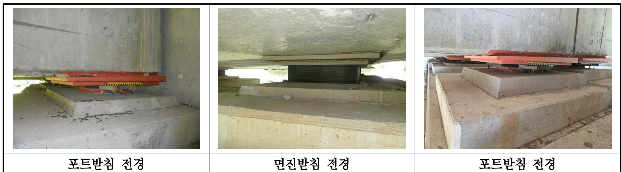
【사진 11.3.13】 교량반침 전경
