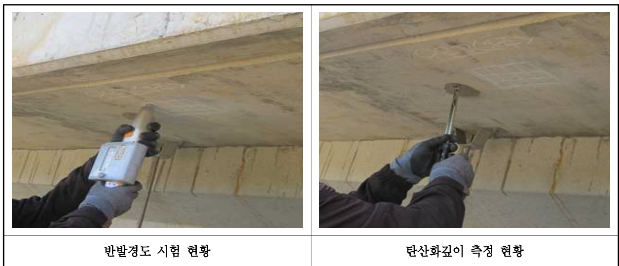
【사진 11.4.1】 콘크리트 내구성조사 현황
